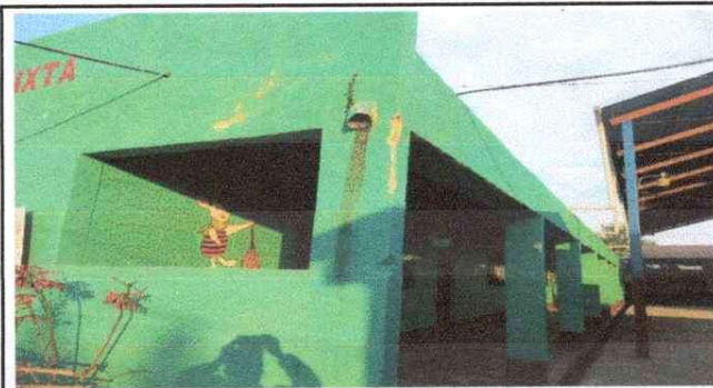
Foto 6: Sustrucción de canal de PVC + Reparación de bajada de agua pluvial, tubo PVC 3"
