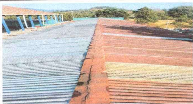
Foto1: Sustrucción de lámina, por lámina troquelada aluzinc calibre 26 + Sustrucción de capote de lamina para lámina troquelada + Sustrucción de elementos de fijación
