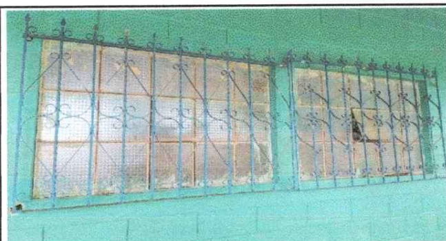
Foto 5: Mantenimiento de balcones de metal
